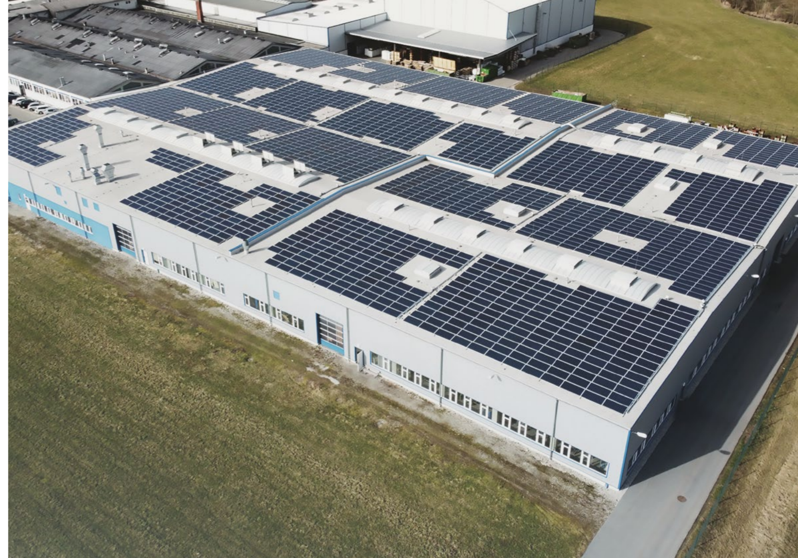
ÖSTERREICH / 799,92 KWP / S05
